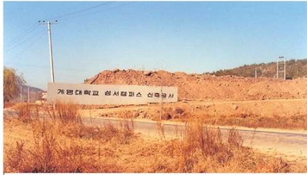
계명대학교 성서캠퍼스 신축공사 현장(1981)
