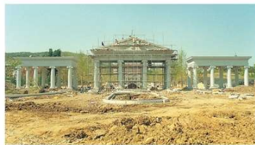
성서캠퍼스 정문 공사 현장(1999)
